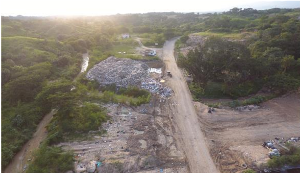
Figura 65. Celda temporal de residuos del relleno sanitario. Fotografía tomada en septiembre 2020.
