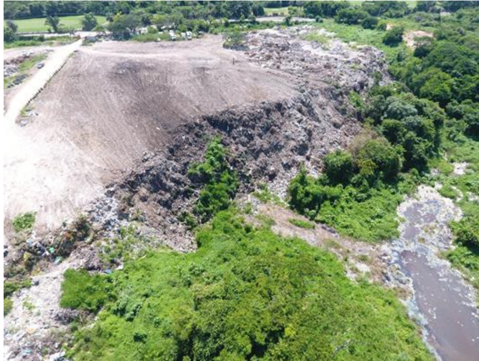
Figura 62. Vista aérea del frente de los taludes en San Nicolás, dirección norte a sur. Fotografía tomada en 30 septiembre 2020.
