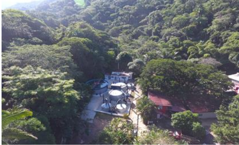
Figura 67. Planta potabilizadora de la playa de Mismaloya. Fotografía tomada en septiembre del 2020.
