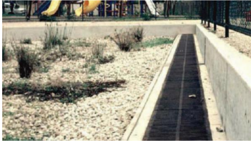
Figura 95. Zanjas de absorción. Fuente: Melbourne Water (2005).
