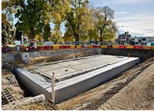
Figura 99. Sistemas de colección de agua pluvial conectados a la red de alcantarillado. Fuente: City of Melbourne, 2013.
