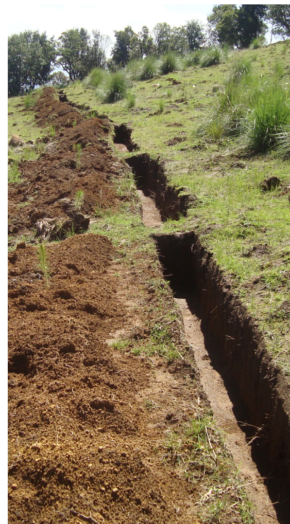
Sistema de Zanja a bordo. Fuente: Tomado de CONAFOR, 2004. Disponible en: https://biblioteca.semarnat.gob.mx/janium/Documentos/Ciga/libros2009/CG008969.pdf
