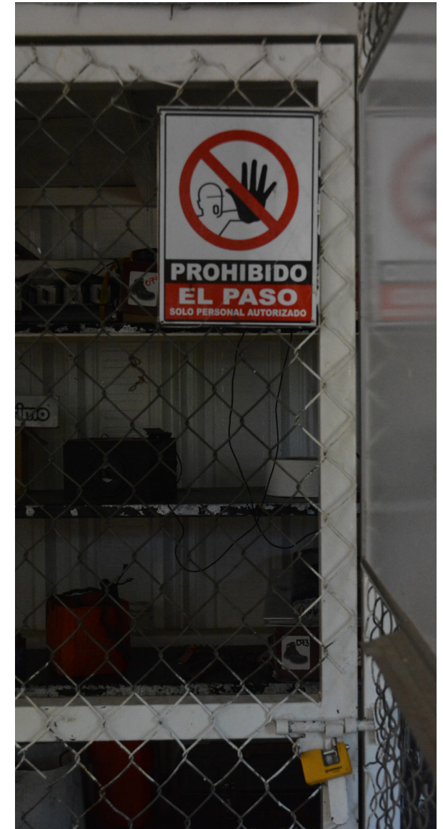
Almacén temporal de residuos señalado y bajo llave.
