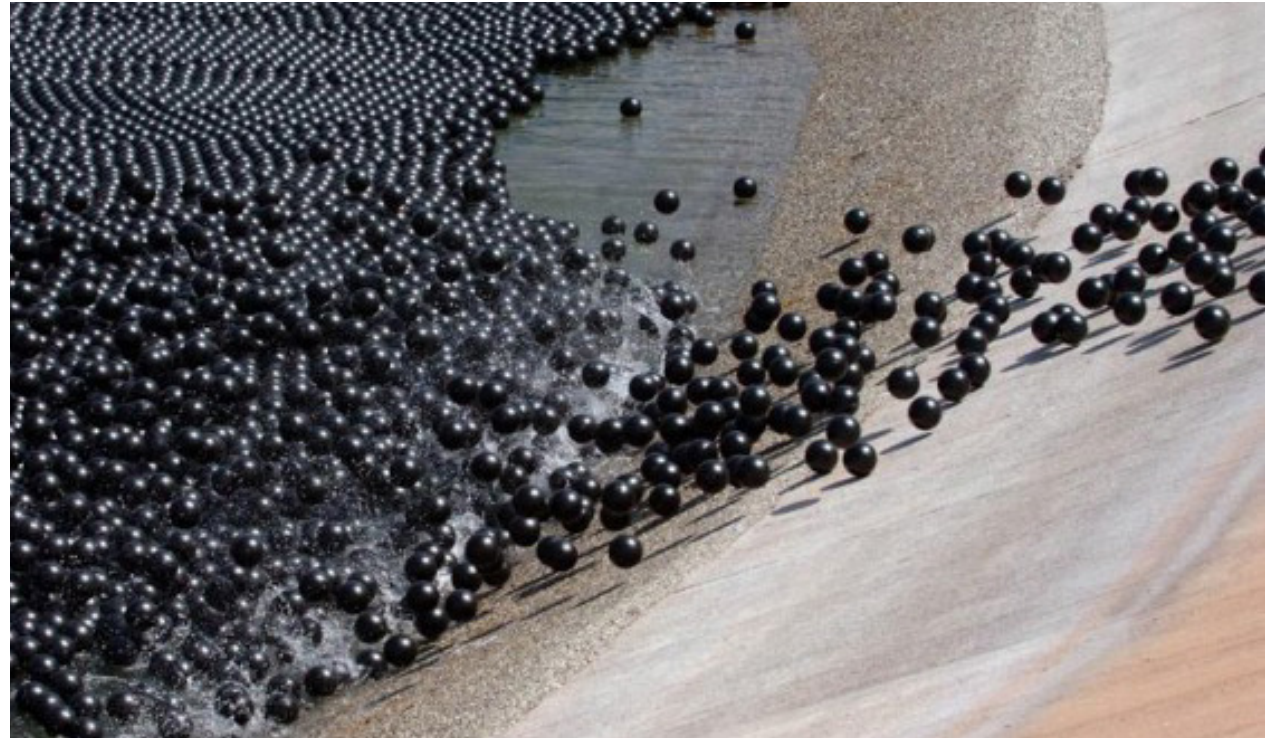
Pelotas de sombra usadas para evitar la evaporación de agua en reservorios. Fuente: Parapedro, s.f.
