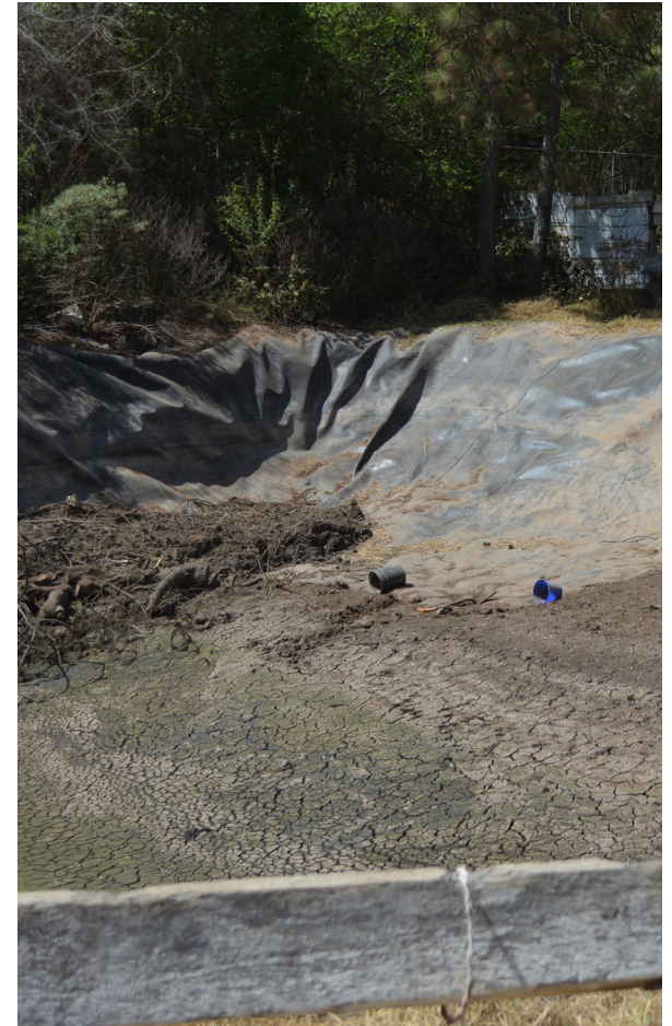
Las ollas de agua construidas con geomembrana pueden ser un peligro para los animales silvestres. Foto tomada en el municipio de Tapalpa.
